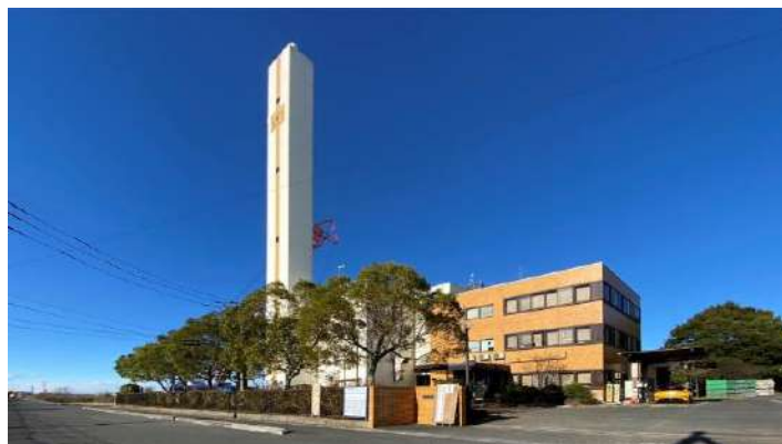
伊奈町クリーンセンター
