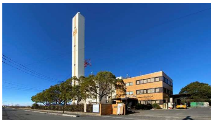
伊奈町クリーンセンター
